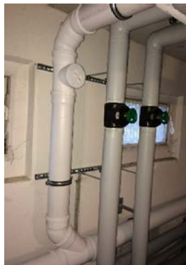
Neu eingebaute Wasser- und Abwasserleitungen mit Brandschutzmanschetten im Kellerge­schos
