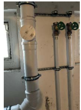
Neu eingebaute Wasser- und Abwasserleitungen mit Brandschutzmanschetten im Kellerge­schos
