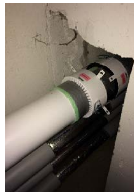
Neu eingebaute Wasser- und Abwasserleitungen mit Brandschutzmanschetten im Kellerge­schos
