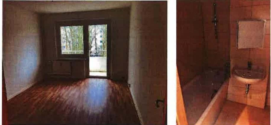
Links: Neuer Bodenbelag und neue Balkontür mit reduzierter Bodenschwelle im Wohnzimmer Rechts: saniertes Badezimmer mit neuen Fliesen und Sanitärobjekten
