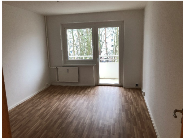
Links: Neuer Bodenbelag und neue Balkontür mit reduzierter Bodenschwelle im Wohnzimmer Rechts: saniertes Badezimmer mit neuen Fliesen und Sanitärobjekten
